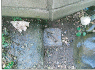
MC16(コンクリート杭)
